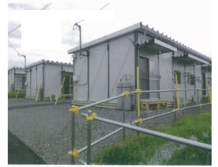
熊本地震における仮設団地
