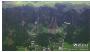
2012年 九州北部豪雨災害 阿蘇市坂梨地区付近の土砂災害
